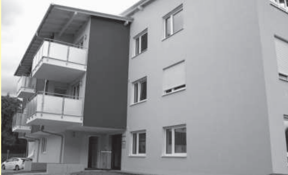
Der erste Bauabschnitt ist fertig und kann bezogen werden.
